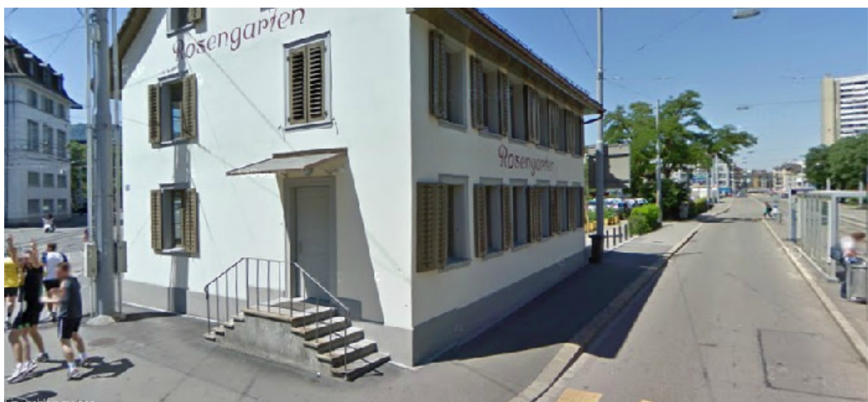
Ehem. Rest. Rosengarten, Kalkbreitestr. 2, 8003 Zürich
